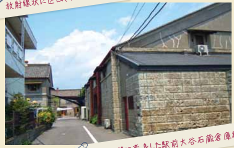
放射線状に区画された駅前街並 レストラン等に変身した駅前大谷石蔵倉庫群
