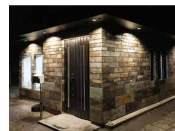
「大谷染石」を使用した同社の本社外壁
